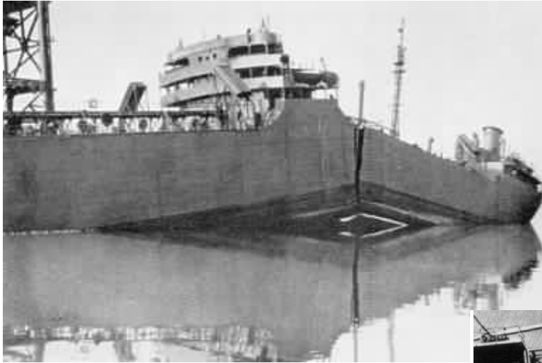
Rotura del petrolero Schenectady
